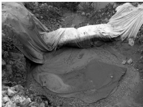
**Figura 4.** Trampa de sedimentos deficientemente instalada, con vertedero inadecuado en la que se está produciendo la salida de material al cauce por falta de mantenimiento
