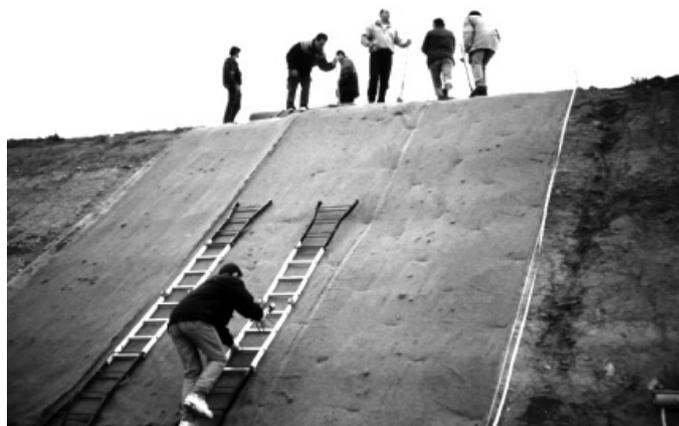
**Figura 14.** Instalación de mantas orgánicas de esparto en taludes de ferrocarril (Palencia)
