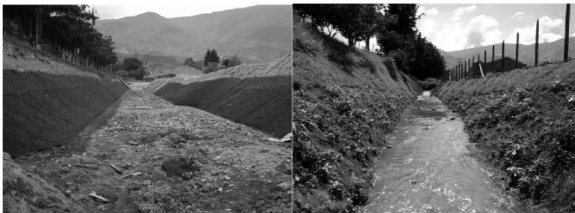
**Figura 15.** Restauración de un canal en Colombia con redes sintéticas (2 D) entre oct. 2001 y en. 2002 (cortesía del Ing. Juan Guillermo Duque)
