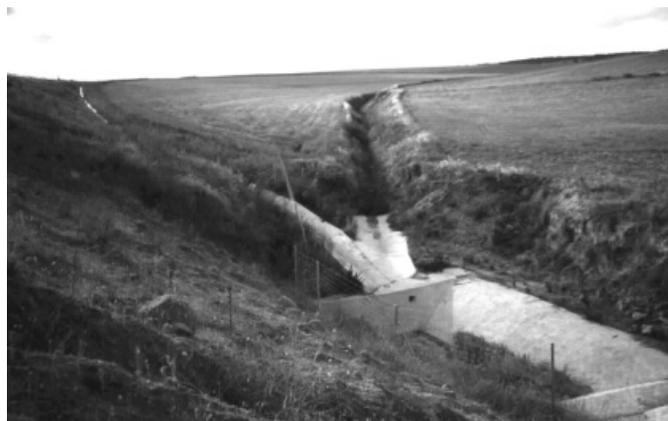
**Figura 3.** Pequeña balsa de decantación en la autovía de Valladolid-Salamanca
