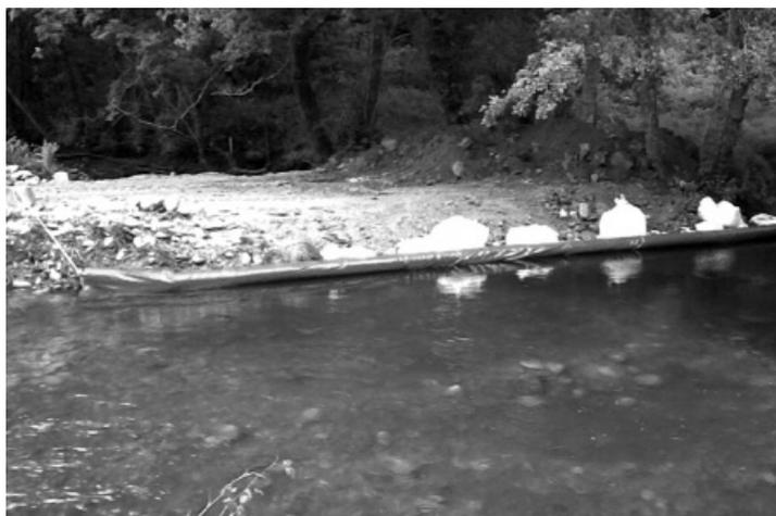
**Figura 6.** Pantalla flotante para control de sedimentos por construcción de una minicentral en el río Umia
