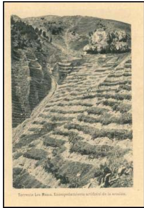
1.4. Encespedamiento para posterior repoblación
