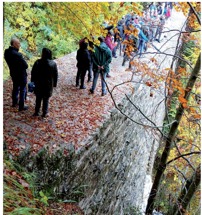
Los participantes, en la coronación de uno de los grandes “diques vacíos” del torrente de Epifanio, construidos para la retención de aludes
