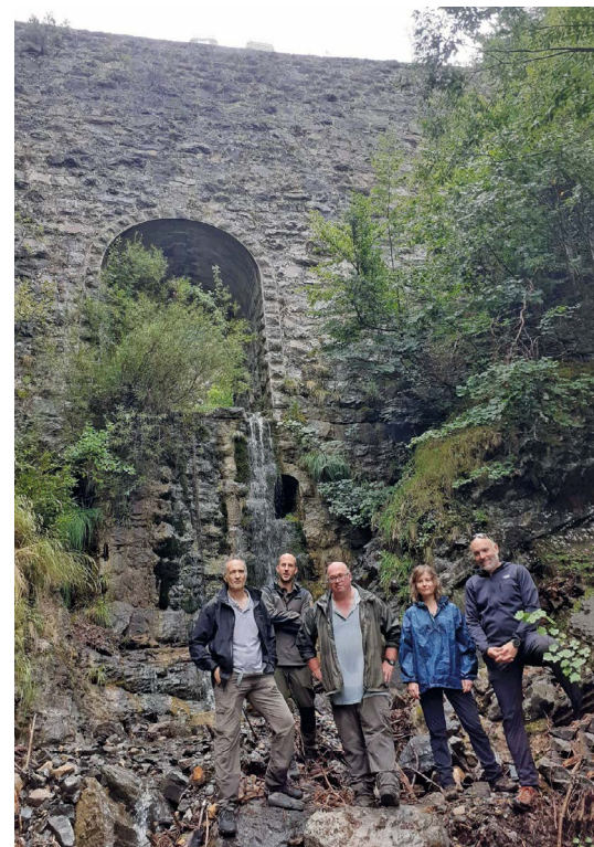
Uno de los grandes diques construidos a comienzos del siglo XX para la retención de los aludes que bajaban por el torrente Epifanio. Este tipo de diques fue inventado por el Ingeniero de Montes aragonés Benito Ayerbe Aísa, y se conoce como “dique vacío”.
