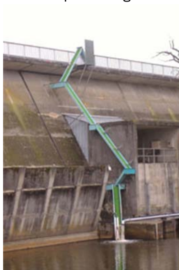
Figura 3. Escala de anguilas en una gran presa.
