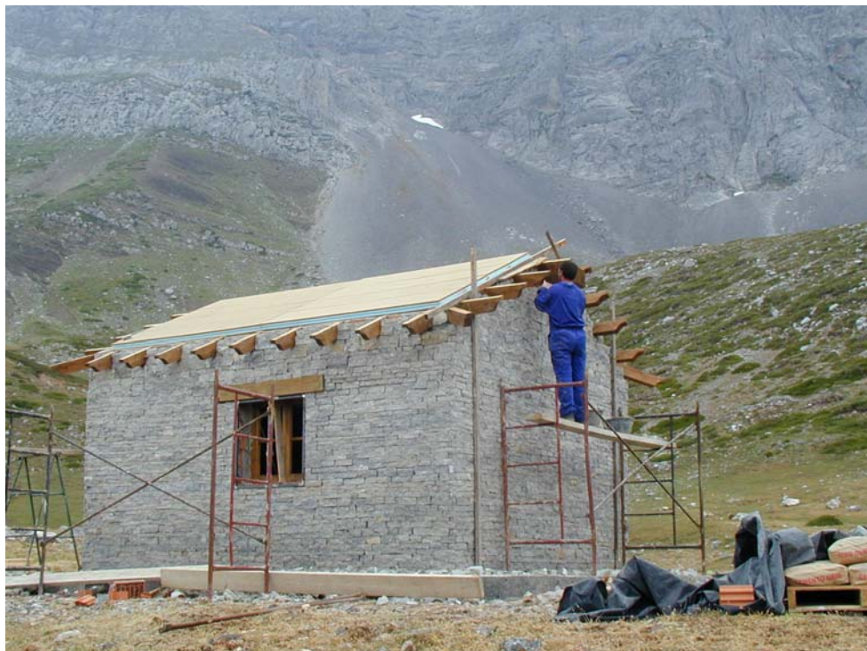
Figura 6. La importancia de la adecuación de infraestructuras: construcción de refugio para pastores acorde con el valor paisajístico del entorno, en “La Becerrera”, del monte de Torrebarrio, a los pies de Peña Ubiña.
