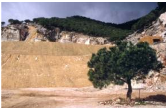
“Al mes de la siembra e instalación de las mantas”
