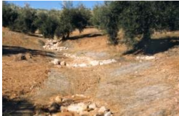
“Sedimentación y control de la bifurcación de las albarradas con mantas orgánicas”.
