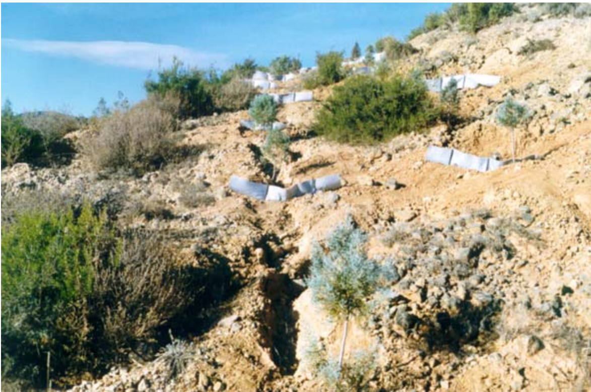
Fotos 4 y 5. Vista de las fajinas con geotextiles ya instaladas. Octubre del 2.000.
