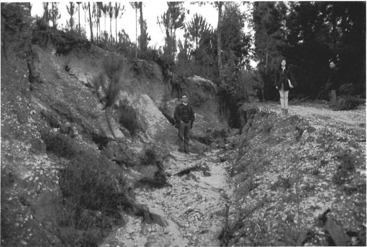
Foto2. Aspecto de la erosión en cárcavas incipientes provocadas por los regueros no corregidos.
